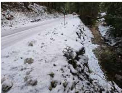
Diese wurden noch kurz vor dem Wintereinbruch durch eine massive Steinschlichtung gesichert.
