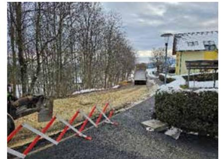
Oben im Bild die gefrorenen Schotterklumpen, welche wahrscheinlich erst im Frühjahr auftauen werden. Unten der fertige Gehsteig mit den eingebauten Straßenleitplöcken zur Absicherung der Regenwasserschächte.
