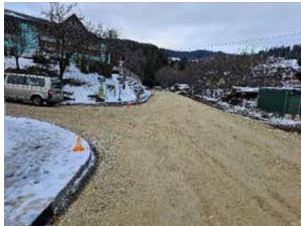
Der großzügig ausgebaute Kreuzungsbereich zum Zeitpunkt der Unterbauverstärkung!
