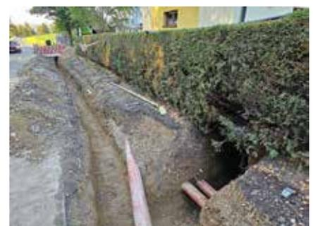
Hier die offenen Künetten zum Zeitpunkt der Sanierung der im Gehsteig verlaufenden Kanäle und Wasserversorgungsleitungen.
