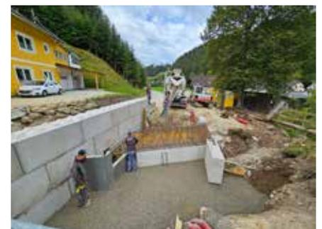
*Zwischenstand 4. Oktober 2023: Die erste Hälfte der Brücke ist in Arbeit, der Brückenkopf oben im Bild wird soeben mit Drainagebeton hinterfüllt.*
