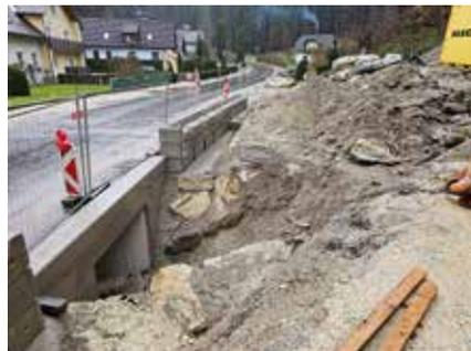
*Zwischenstand 24. November 2023: Der Bach fließt noch durch die Bypassrohrleitung, welche zu Baubeginn verlegt wurden.*
