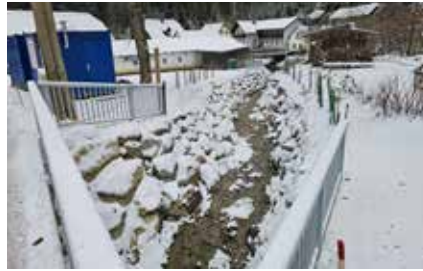
Blick von der Gehwegbrücke Richtung Feistritzeinmündung
