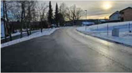
Der neue Asphalt mit Entwässerungsmulde bei der Kräftereich-Abfahrt.
